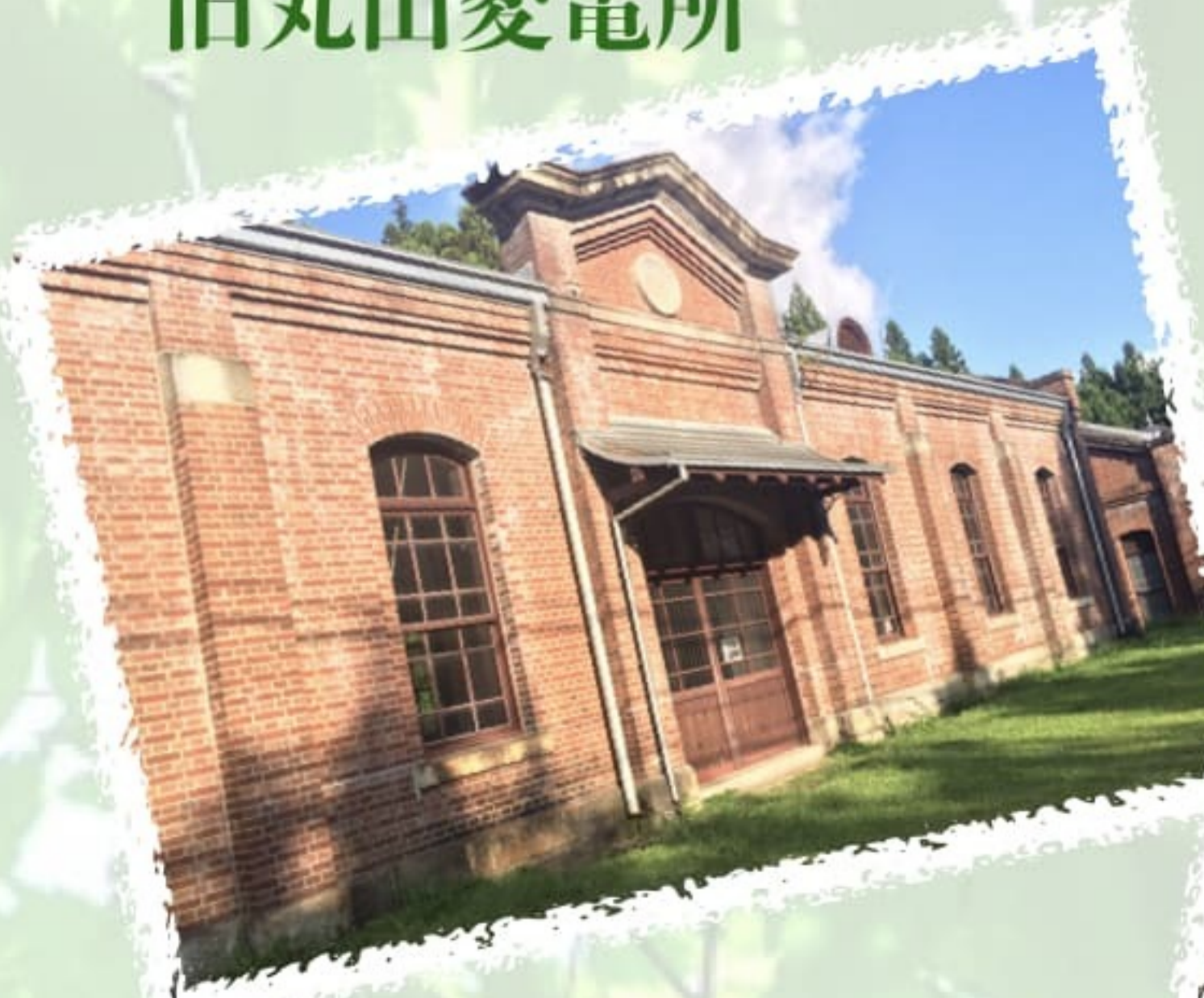
旧丸山変電所
